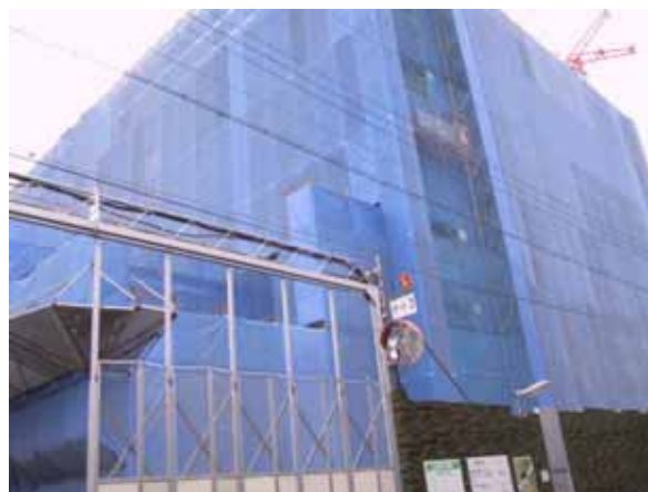
工事現場の全景
